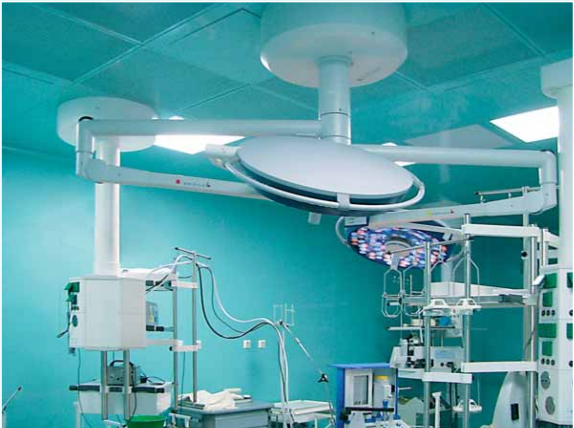
Кріплення операційної стійки до підвісної стелі. The ceiling mounting of operational control console. Крепление операционной стойки к подвесному потолку.
