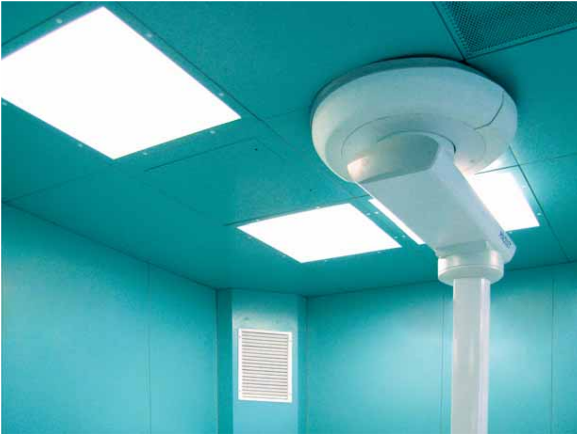
Кріплення операційної стійки до підвісної стелі. The ceiling mounting of operational control console. Крепление операционной стойки к подвесному потолку.
