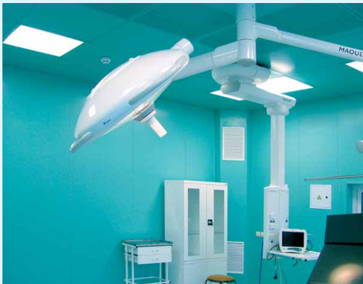
Кутувий витяжний блок. The corner exhaust blok. Угловой вытяжной блок.
