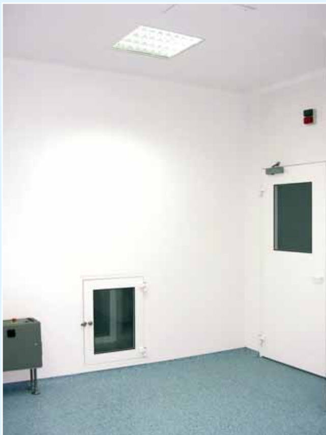
Передавальні шлюзи. The transfer sluices. Передаточные шлюзы.
